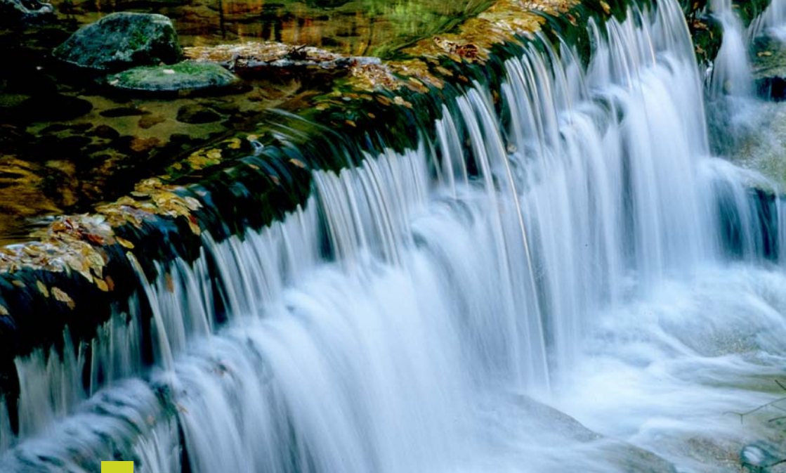
Fot. 39. Przegradzanie w poprzek korytka potoku sztucznymi progami i zabudową przeciwrumoszową, stanowi przeszkodę uniemożliwiającą migrację ryb. Powstanie takiej konstrukcji jest niemal jednoznaczne z ustąpieniem ryb z odcinka ciekła wodnego położonego powyżej zabudowy
